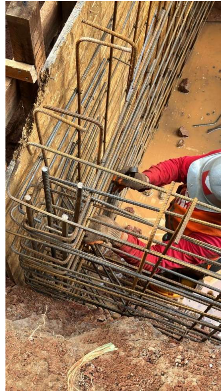
Tanque Inferior – Trabajos en Planta Baja
